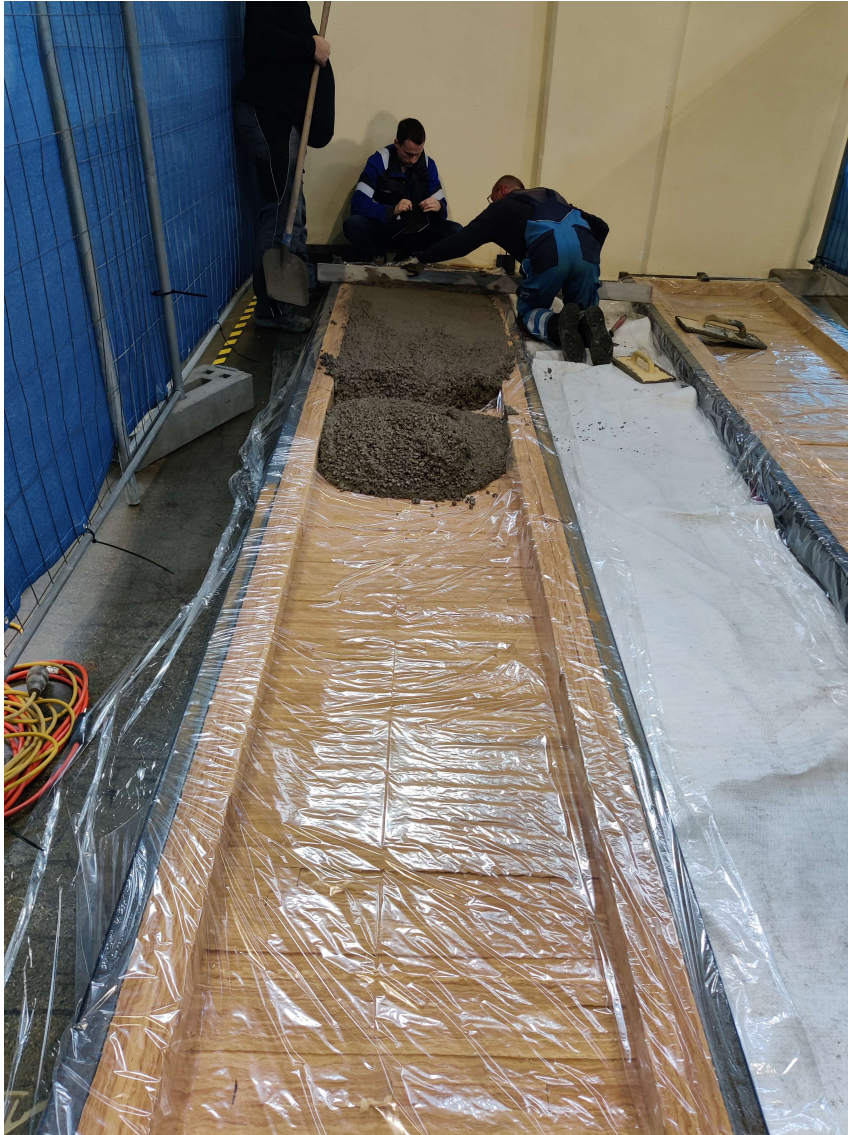
Betoneinbringung
