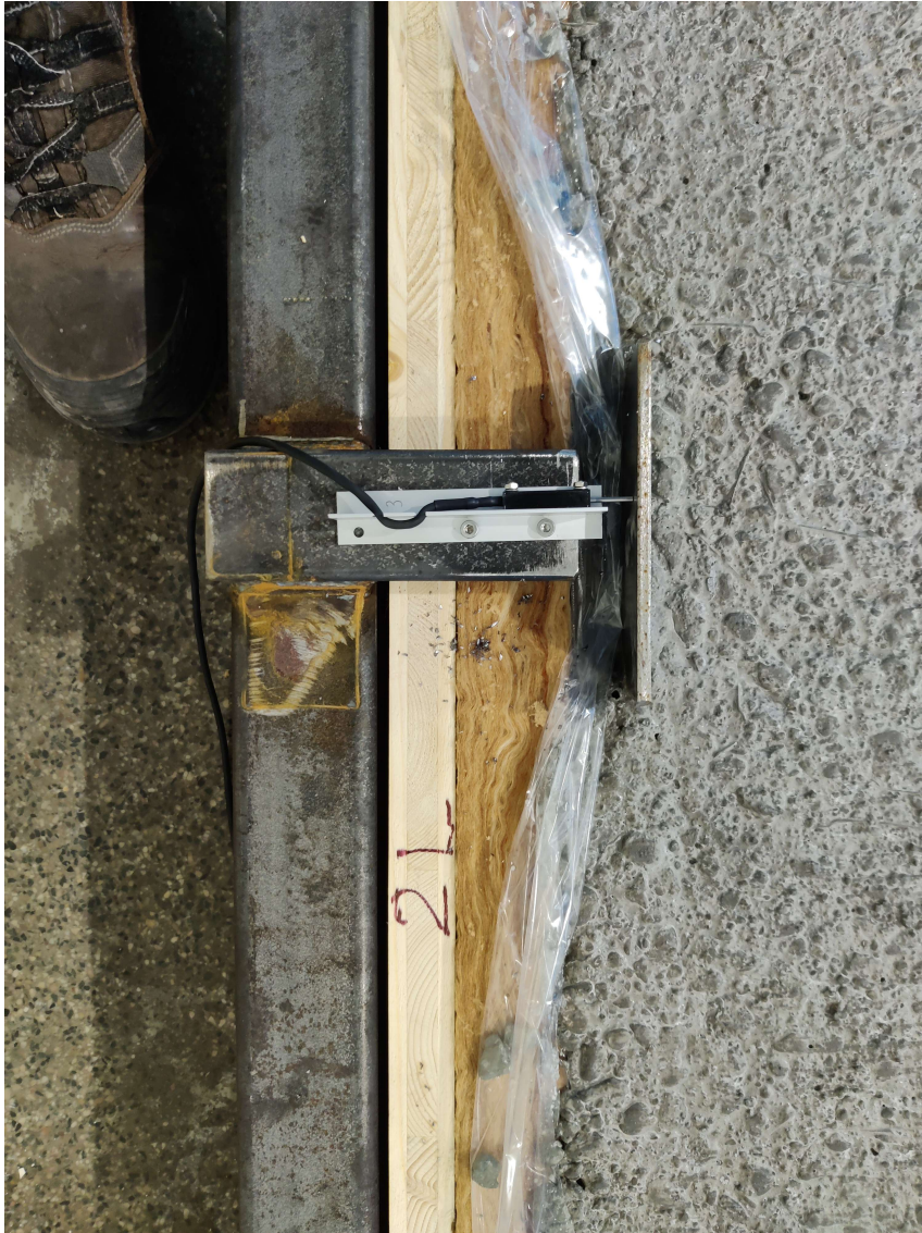
Schalungsende mit Wegmessgerät
